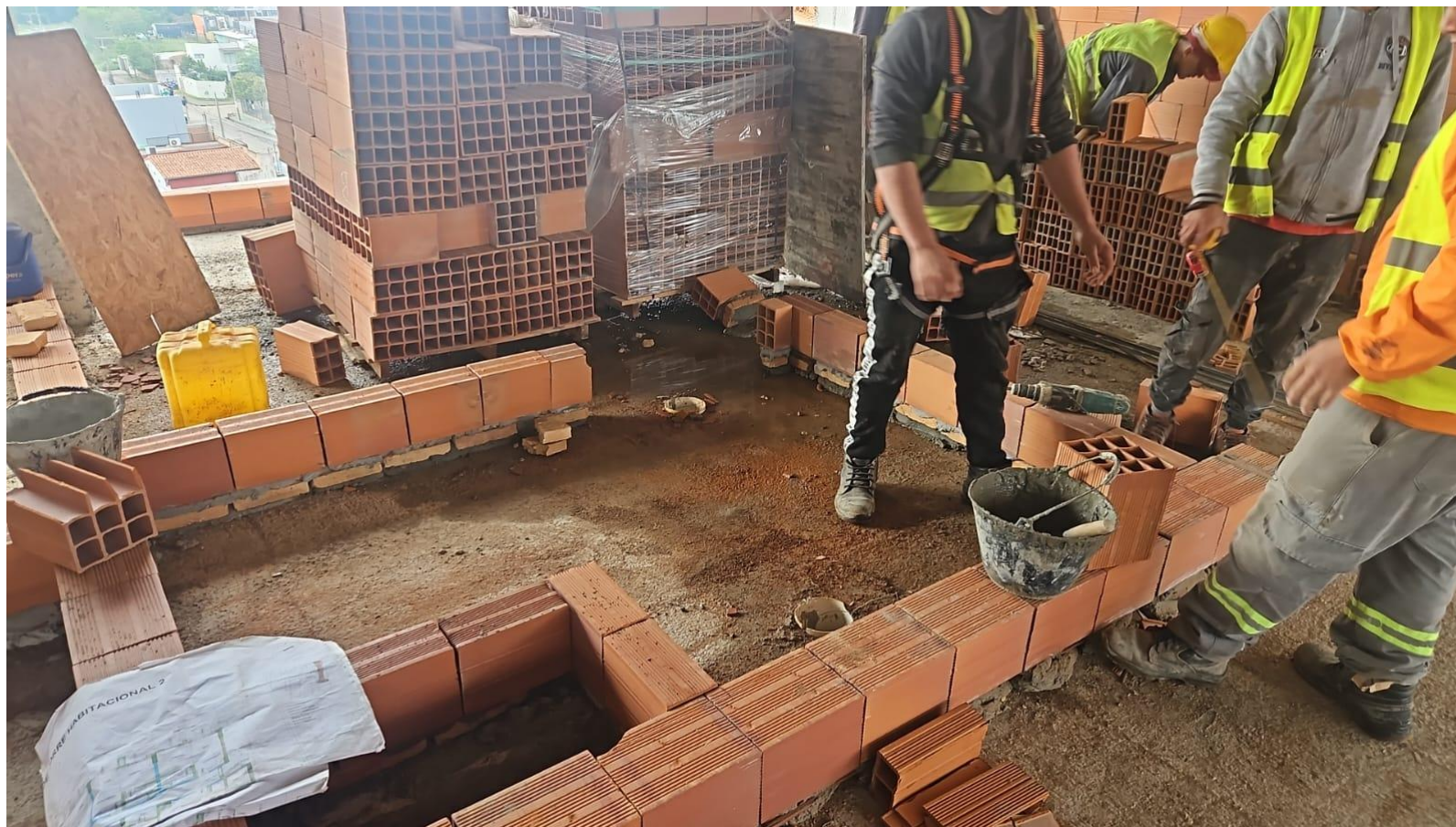
Replanteo de mampostería en el Nivel 7
