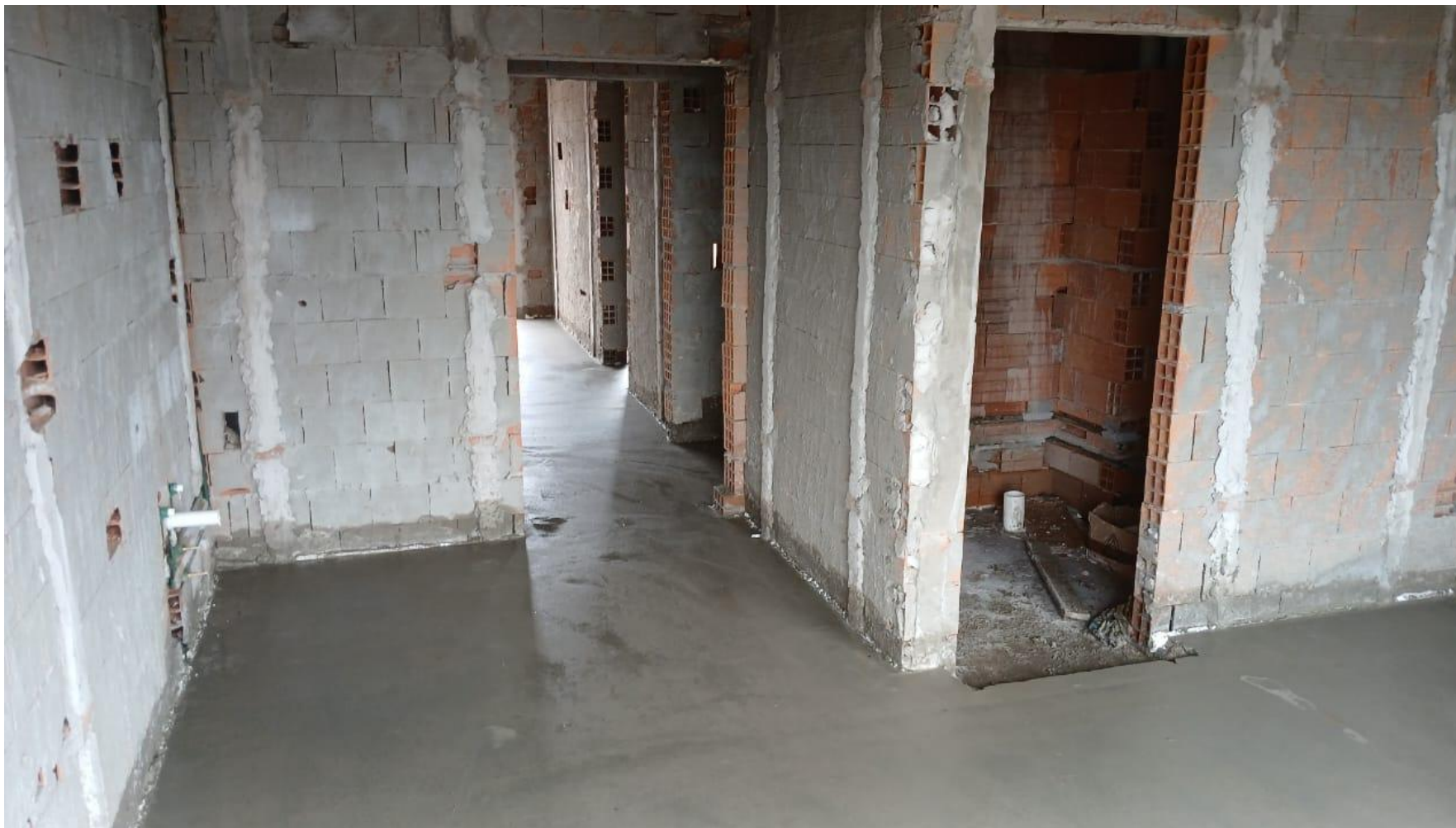
Carga de RDC en el Nivel 4
